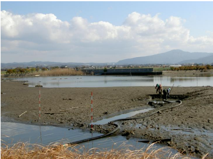
ホース先端の堆積土砂吸引状況
