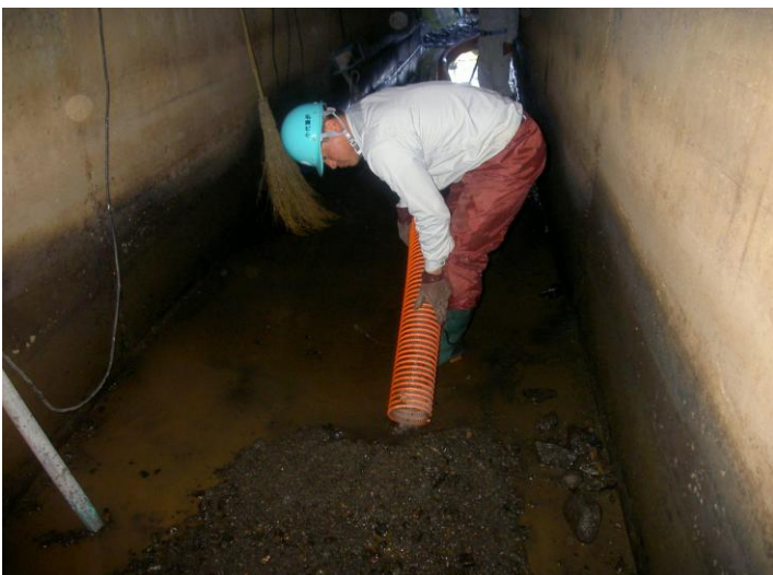
ホース先端の堆積土砂吸引状況
