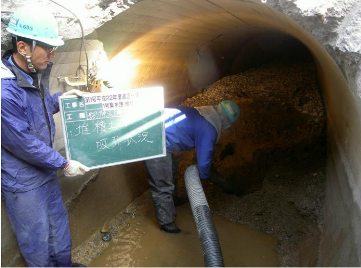
ホース先端の堆積土砂吸引状況（埋没率75%）
