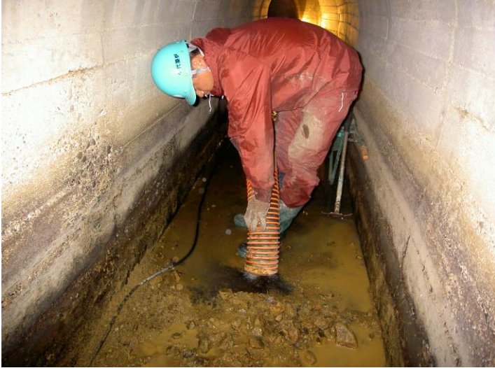
ホース先端の堆積土砂吸引状況
